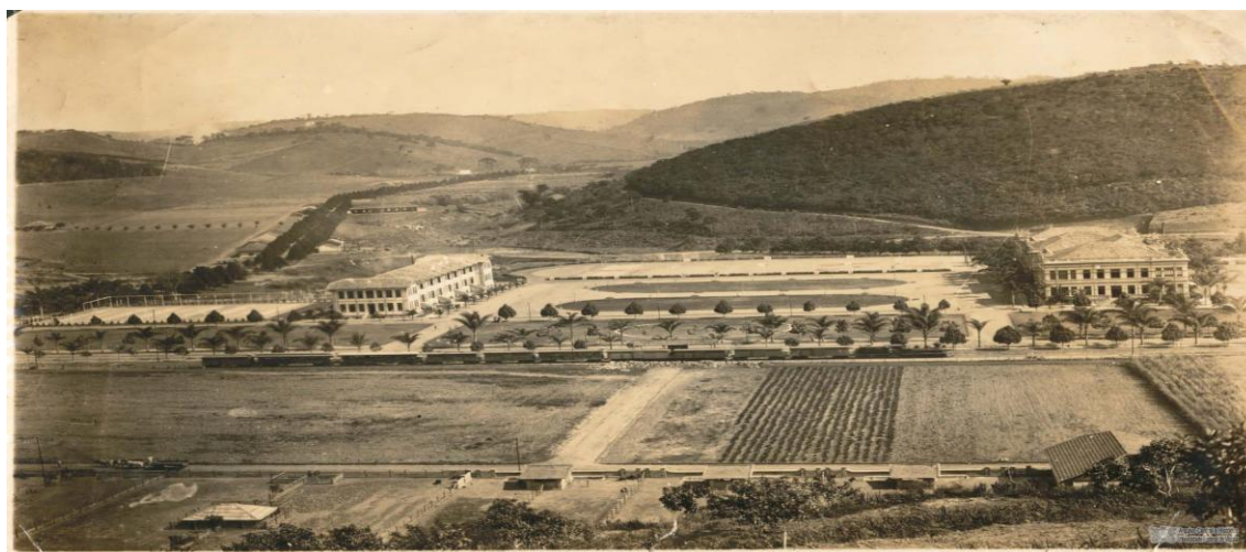
Figura 4- Vista parcial da ESAV – década de 1920. Fonte: Arquivo Central e Histórico.
