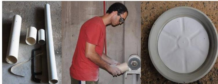
Figura 1: Corte dos canos de PVC; ajuste de medidas; colagem do polímero EVA no interior do prato de vaso de flor. Fotos: Edson Soares Fialho e Rafael de Souza Alves.
