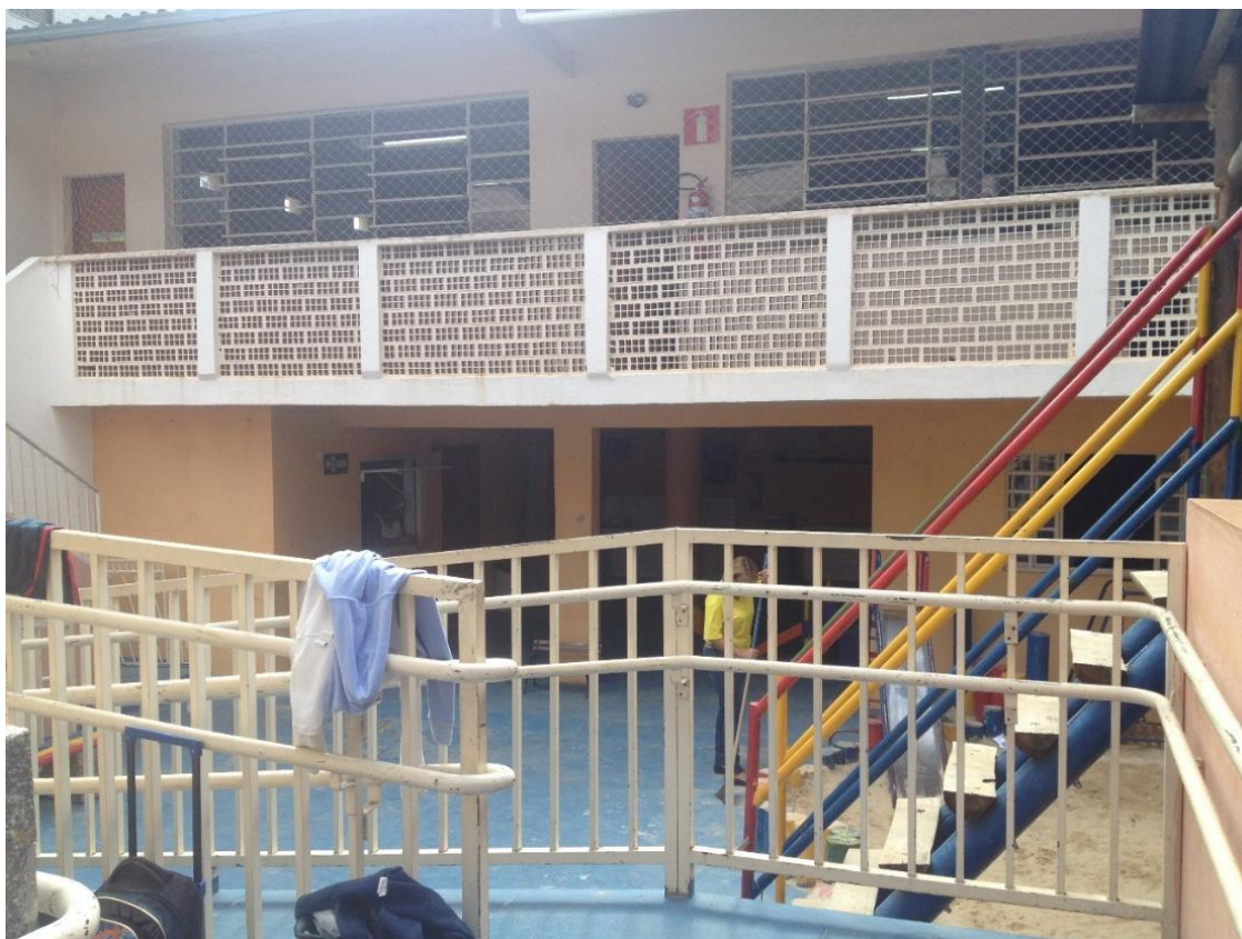
Figura 12 - Final do corredor externo.
